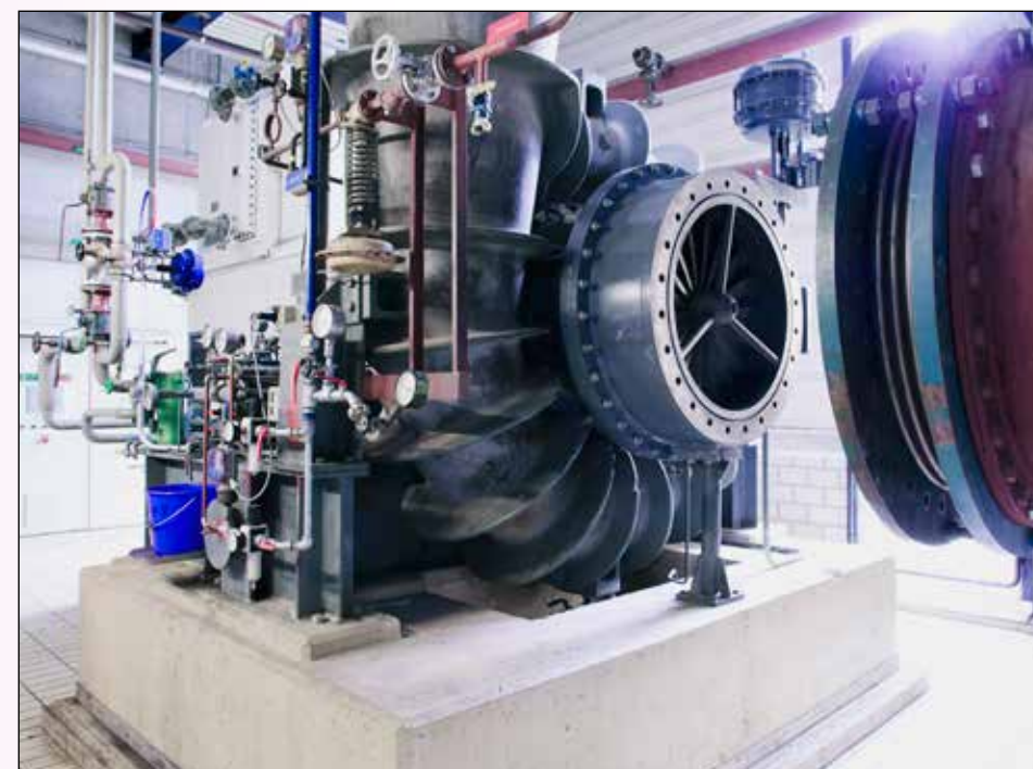
Een studie bij Dow Benelux wijst uit dat opwaarderen van reststoom met een MDR-installatie bijna altijd goedkoper is dan stoomproductie met aardgas. (Foto: AtlasCopco)
