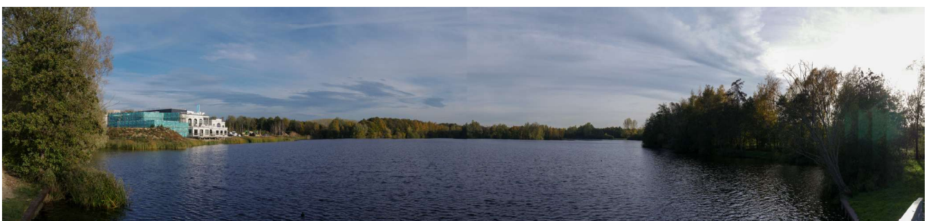
zuidelijke plas: wellnessresort in aanbouw
