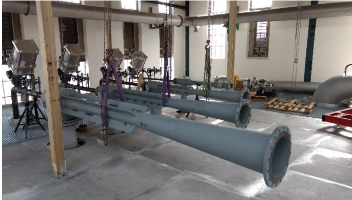
Foto2: De Flex-TDR installatie bij Cosun Beet Company Dinteloord in aanbouw
